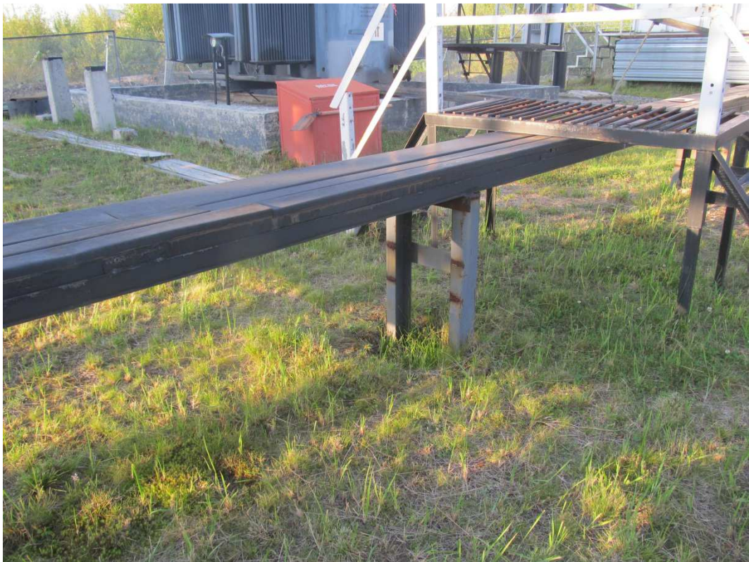
Рисунок А.4 - Общий вид кабельных каналов на ПС 110/10 кВ Ун-Юган КРЭС
