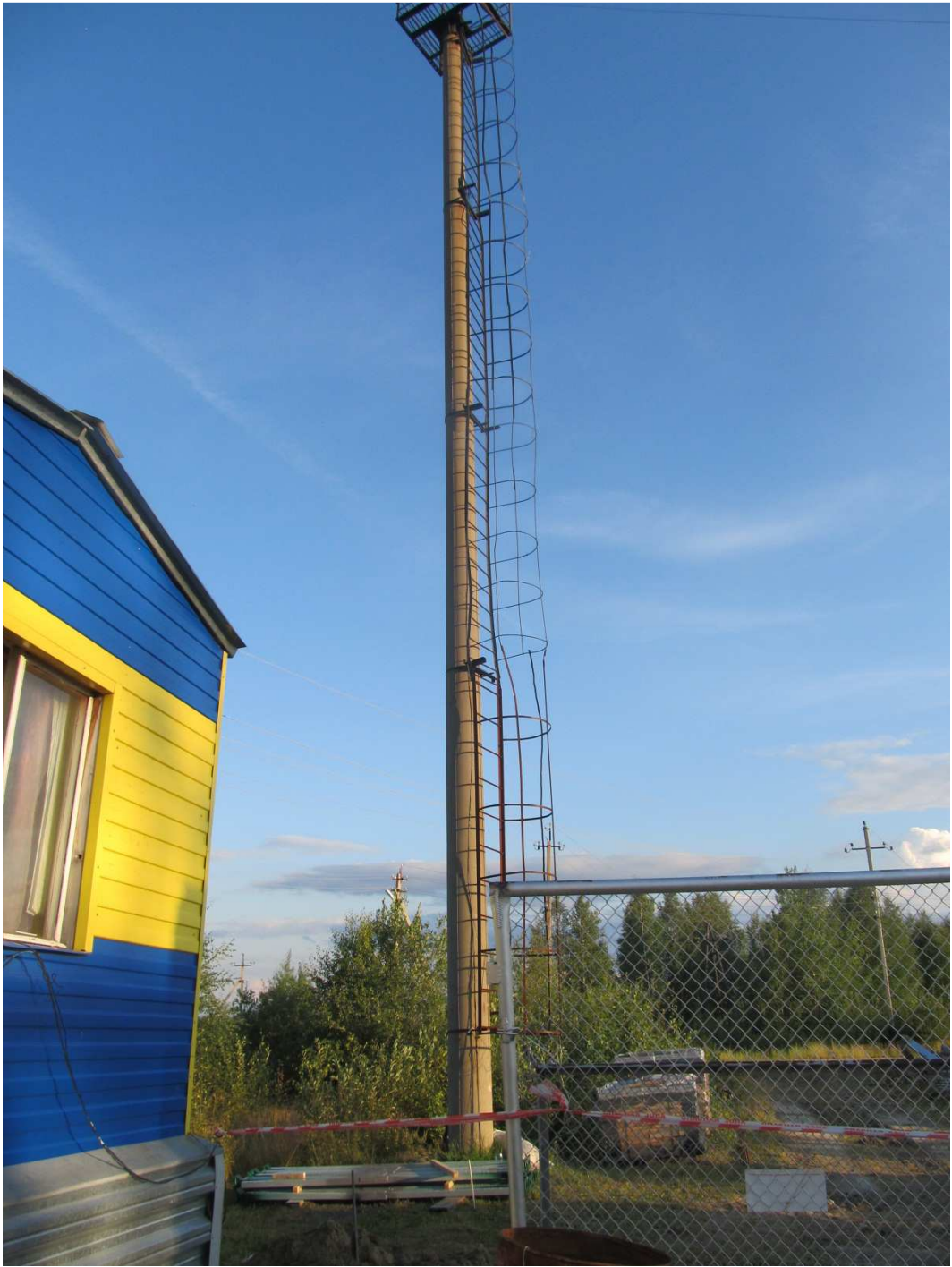
Рисунок А.5 - Общий вид молниеприемника на ПС 110/10 кВ Ун-Юган КРЭС
